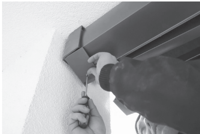
Fig. 16: Rimuovere le coperture delle mensole
