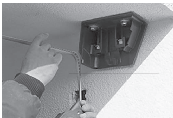
Fig. 07: alignement des consoles (exemple de fixation plafond)
