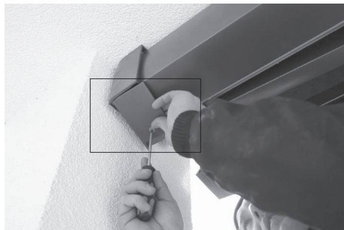
Fig. 12: pose des caches avec store légèrement ouvert
