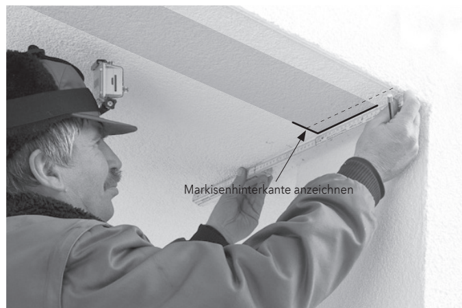
Abb. 04: Markisen-Hinterkante anzeichnen (hier Bsp. Deckenmontage)
