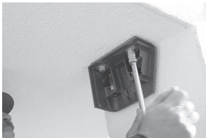
Fig. 08: serrage des vis (exemple de fixation plafond)
