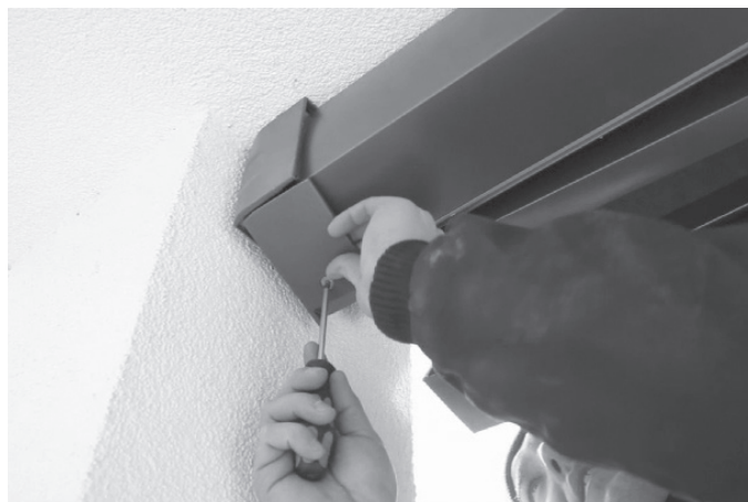
Figura 16: Retirar las cubiertas de los soportes
