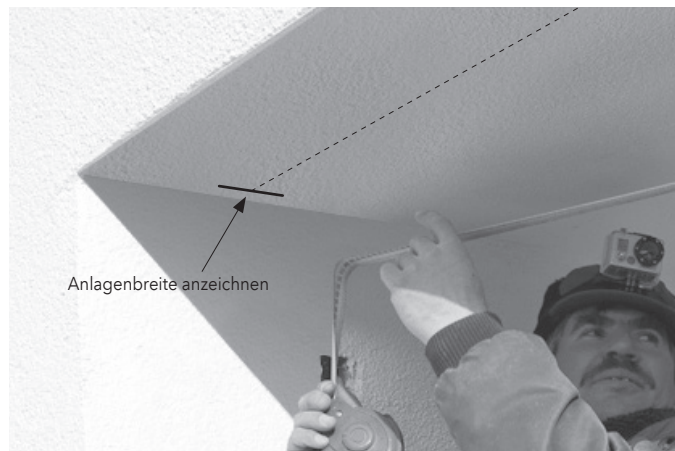
Abb. 03: Anlagenbreite anzeichnen (hier Bsp. Deckenmontage)
