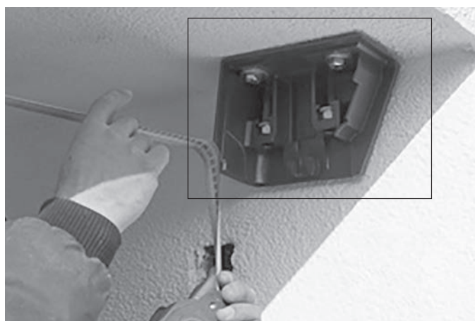
Fig. 07: Allineare le mensole (qui nell'esempio il montaggio a soffitto)
