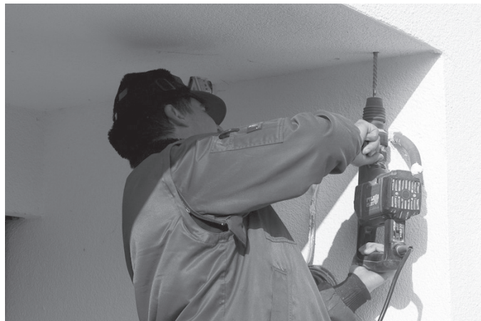
Abb. 06: Bohrungen setzen (hier Bsp. Deckenmontage)
