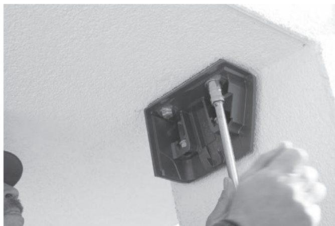
Abb. 08: Befestigungsschrauben anziehen (hier Bsp. Deckenmontage)
