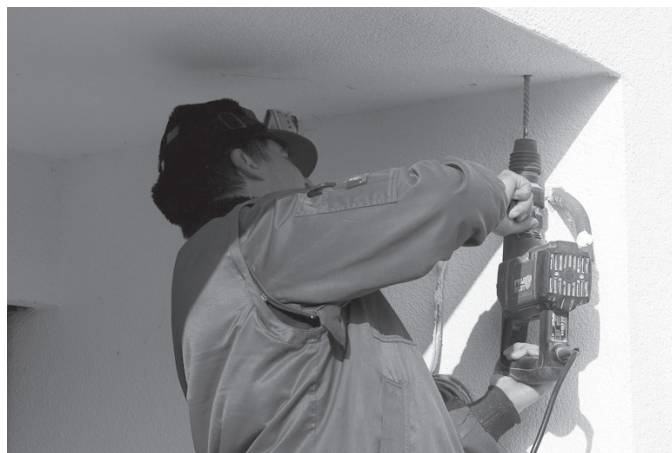
Fig. 06: perçages (exemple de fixation plafond)
