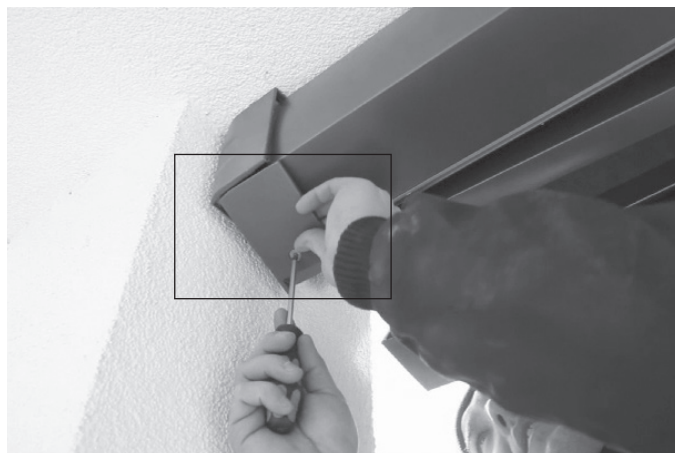
Figura 12: Instalar las cubiertas con el toldo ligeramente abierto
